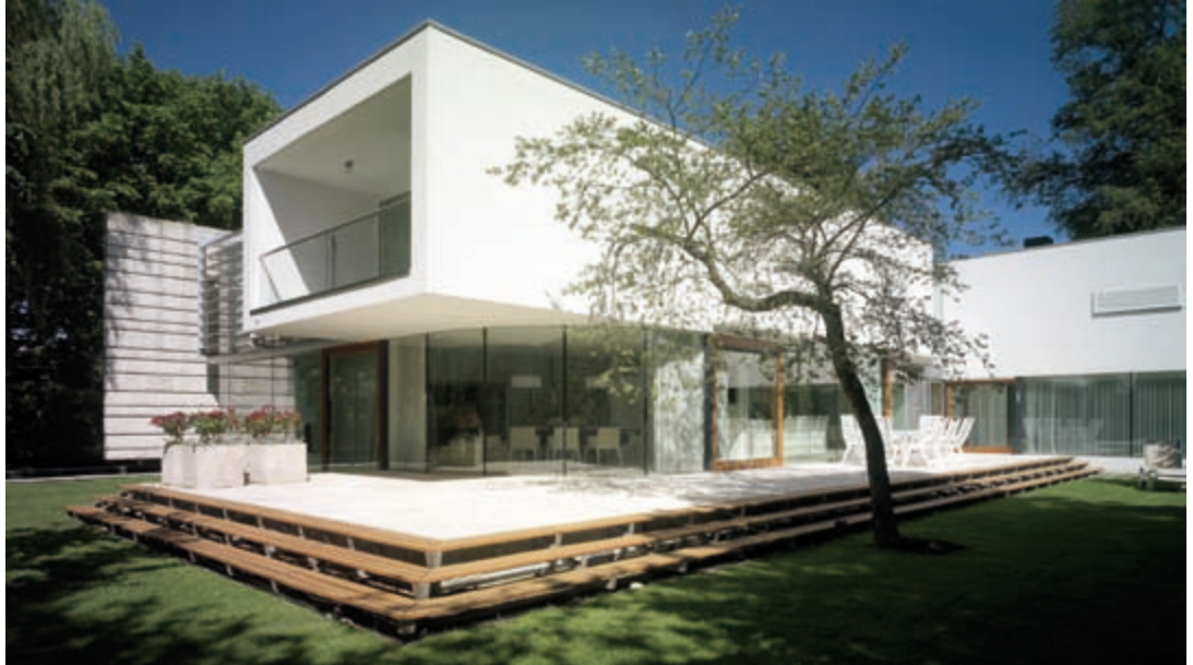
Dom jednorodzinny w Minervalaan, Holandia. Zastosowano system ispotherm A.
